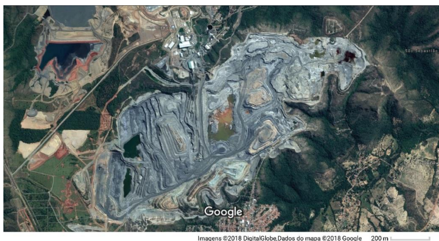
Figura 43 – Imagem aérea da mina de ouro de Paracatu – MG.
