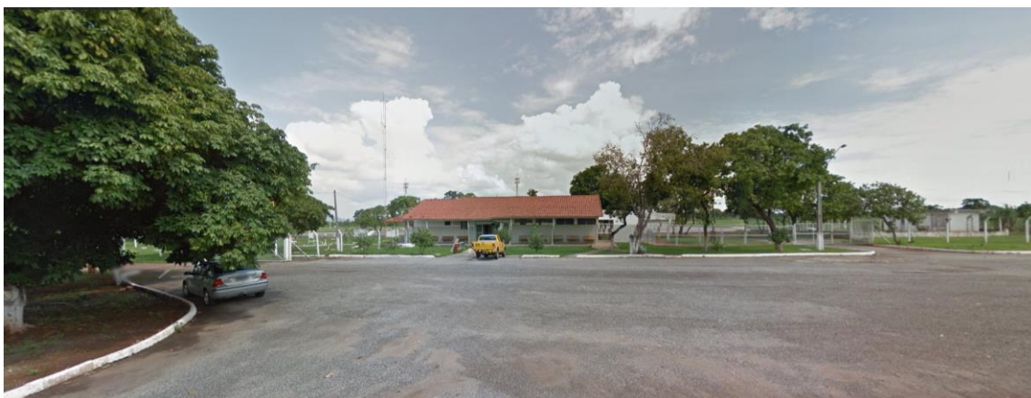
Figura 6 – Aspecto da fachada principal do aeroporto de Porto Nacional (TO).
