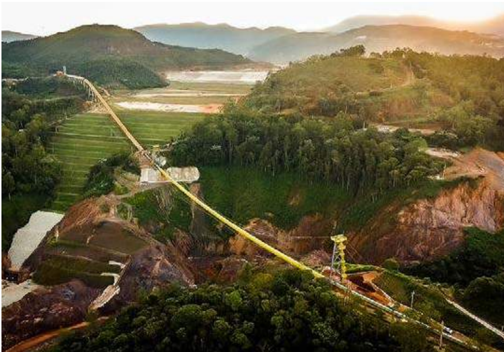
Figura 2. Ramal do TCLD reconstruído em complexo mineral de Minas Gerais
