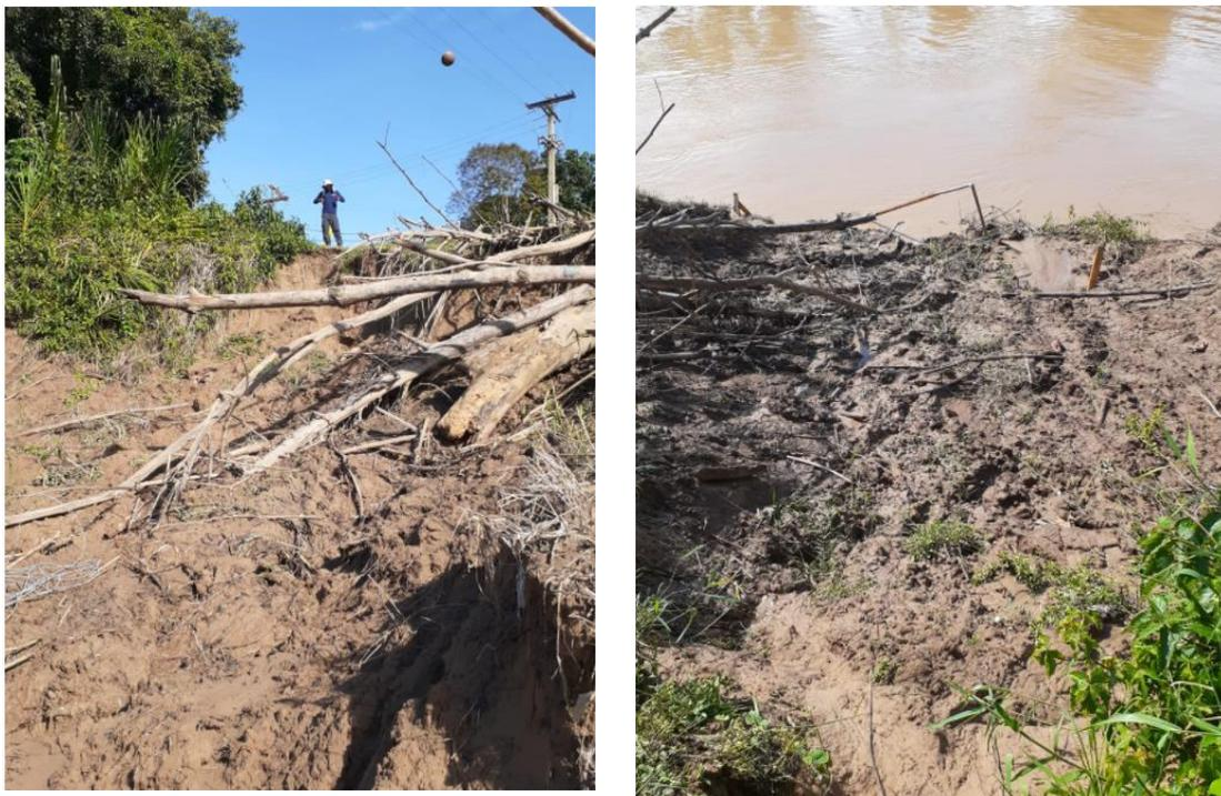
**Figura 5:** Fotos da estação de Xapuri enviadas em 17 de janeiro de 2020, onde ocorreu o desbarrancamento da margem do rio no trecho da estação.
