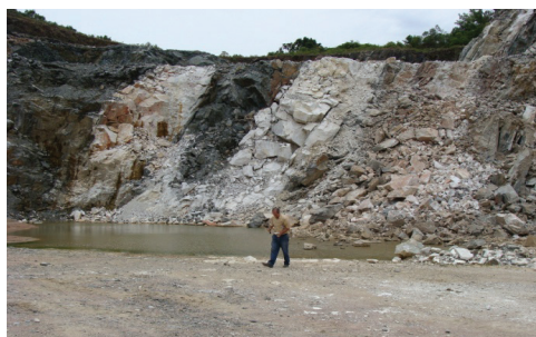
Figura 8. Piso da Mina da Palma, ao fundo mármore calcítico empregados na indústria de cimento e xistos máficos em intrado de dobra.
