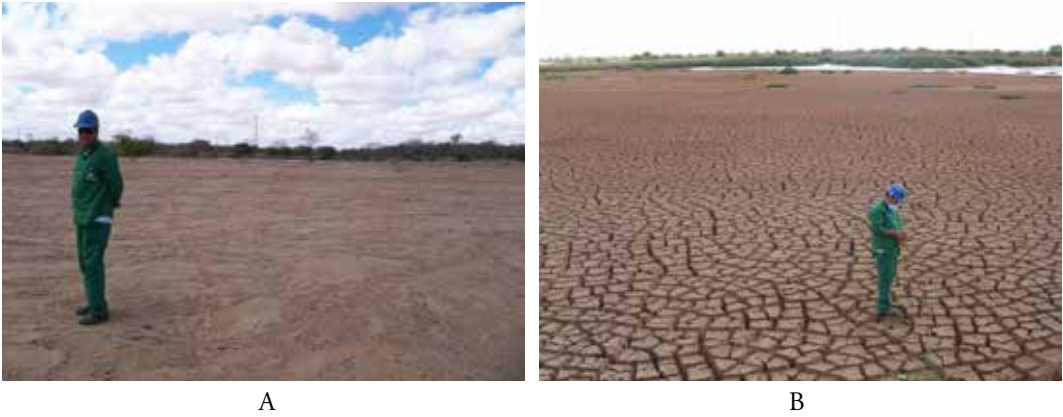
Figura 5 – A: Bacia de rejeito de flotação da empresa Galvani, em Irecê, com polpa inconsolidada. B: Bacia de rejeito de deslamagem, com alta proporção de argilas, gerando compactação e gretas de contração após a secagem.
