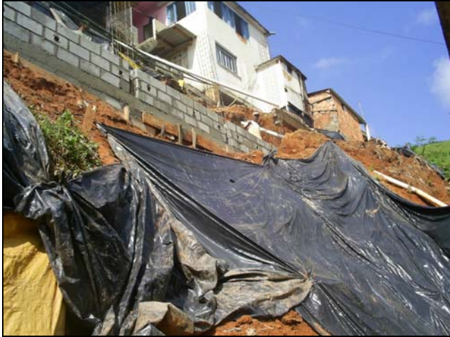
Foto 12 – Moradores erguendo muro de contenção por sobre recente deslizamento.
