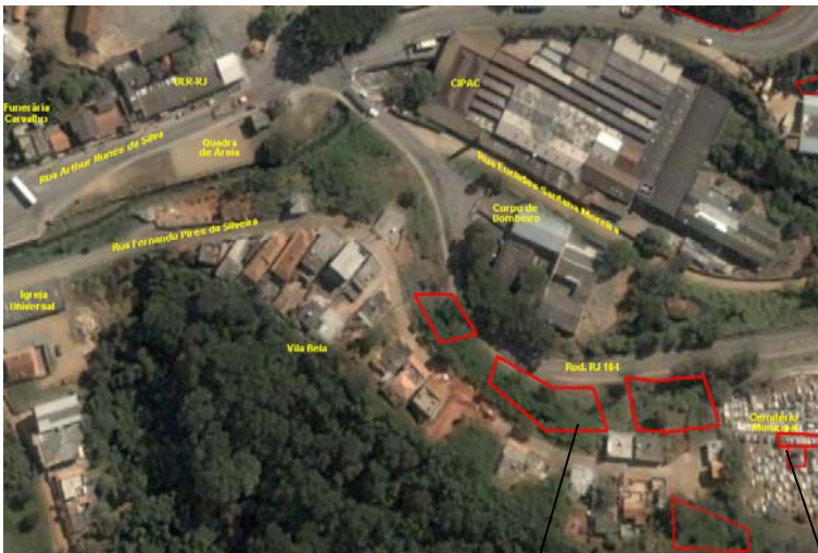
Foto 13 – Vista aérea extraída do Google Earth, em vermelho os diversos locais de ocorrências catalogados em janeiro de 2007 pela Defesa Civil.
