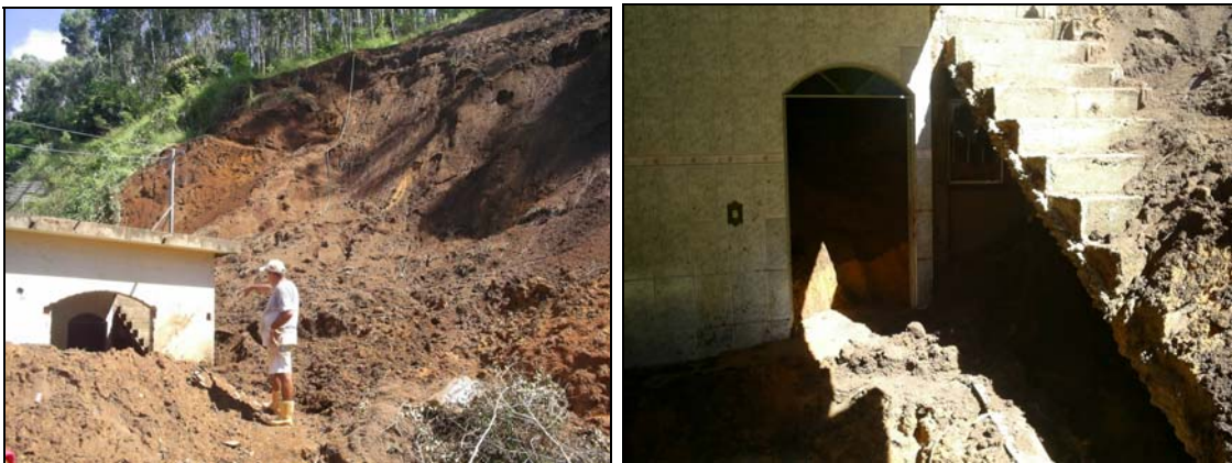
Fotos 16 e 17 – Deslizamento em Sta Rita da Floresta.
