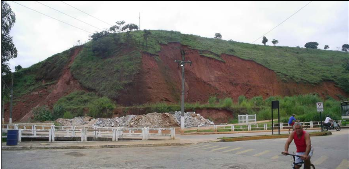
Foto 2 – Próximo ao Centro, deslizamento circular em local onde seria implantado a Delegacia Legal. Espesso pacote de colúvio e solo residual maduro desestabilizado pela saturação de água no terreno e obras no local.
