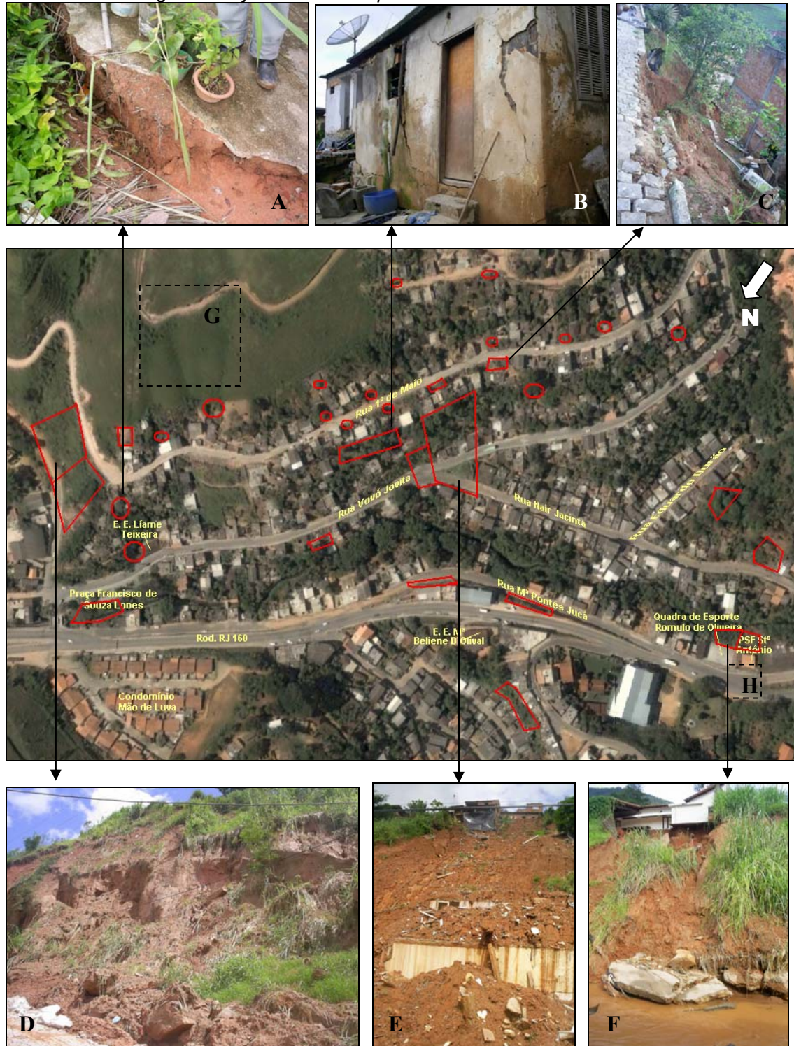
Foto 5 – Ao centro, vista aérea extraída do Google Earth, em vermelho os diversos locais de ocorrências catalogados em janeiro de 2007 pela Defesa Civil.
