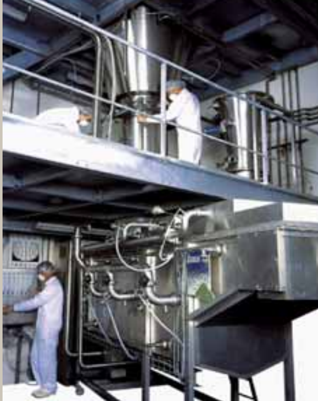
◀ Photo 11 : Atelier d'atomisation et séchage en lit fluidisé dans l'industrie pharmaceutique.
