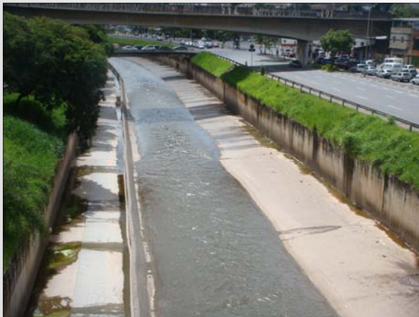
Fonte: < http://alarq.blogspot.com.br > Retificação e rebaixamento de canal, Belo Horizonte – MG.
