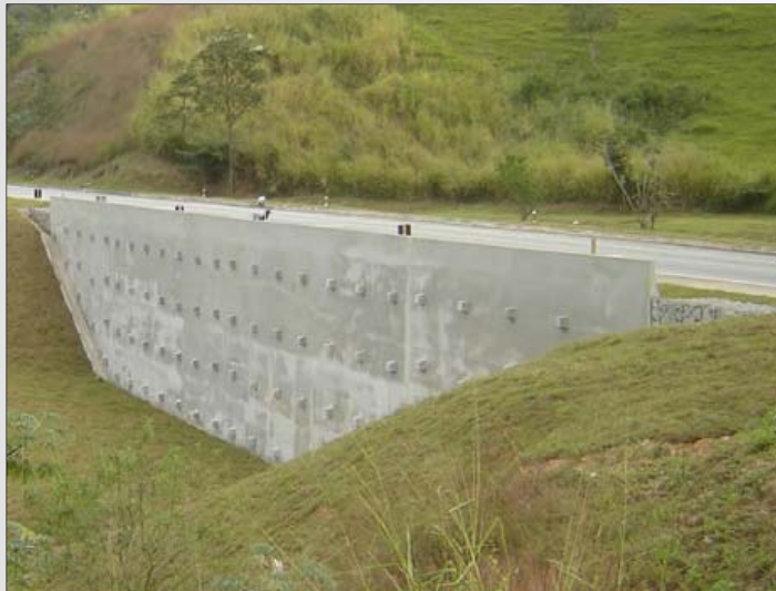
Créditos: SOPE Engenharia Cortina atirantada
