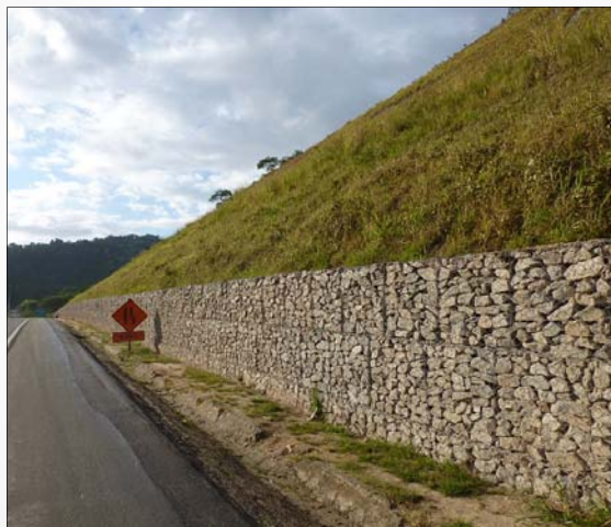
Créditos: ENG Consultoria e Projetos Muro de gabião
