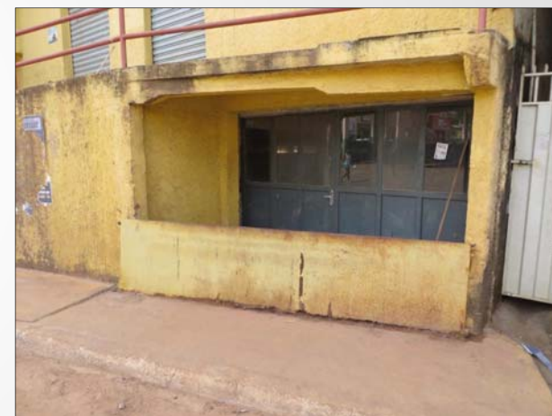
Créditos: Júlio Lana CPRM/SGB. Comportas em residências na área afetada.
