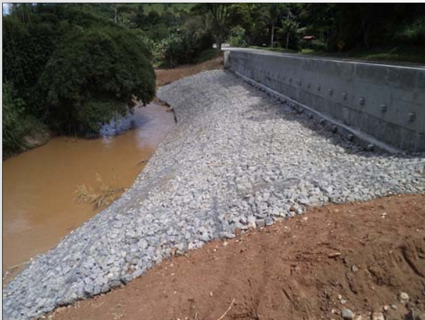
Créditos: SOPE Engenharia Enrocamento contra erosão
