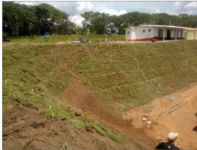
Proteção da face do talude com gramíneas.
