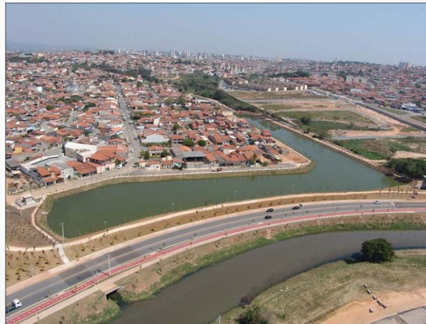
Créditos: SAAE Sorocaba Reservatório para controle de cheias
